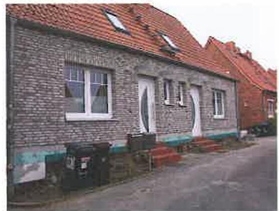
Abbildung 6: Umbau eines Doppelhaus – neue Fassade mit grauem Sichtmauerwerk
