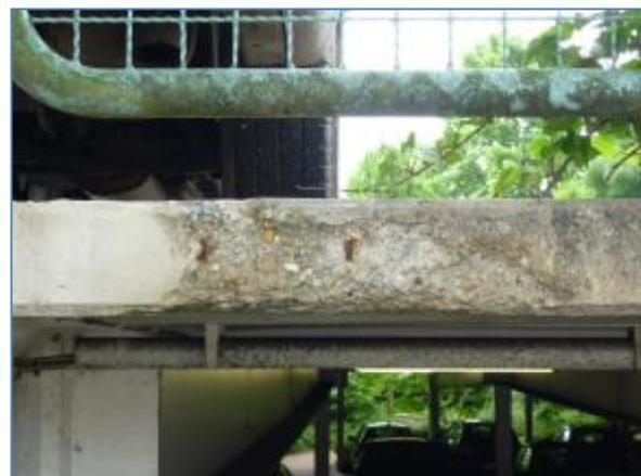
*Bild 7.4: Betonabplatzungen, Korrosionsschäden am Stahlbeton-Bewehrungsstahl*
