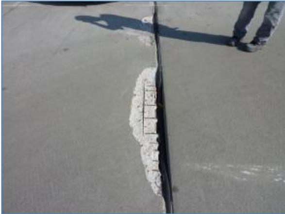
*Bild 7.5: Betonabplatzungen an
