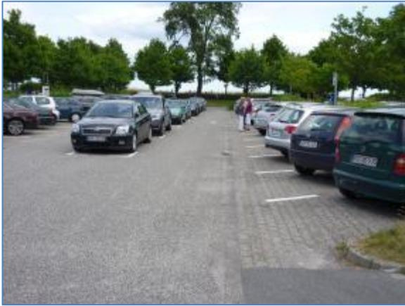
Bild 3.6.1: Längsaufsteller und Parktaschen Am Exer (P 4) mit zu geringem Rangierraum
