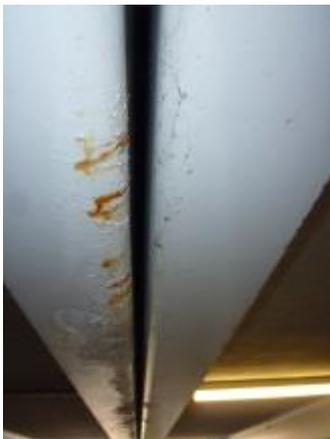
*Bild 7.3: Korrosionsschäden am Stahlträger*
